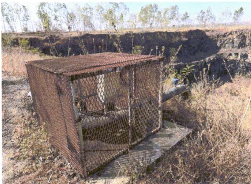
เครื่องสูบน้ำระบบไฟฟ้าขนาด 315 แรงม้า
